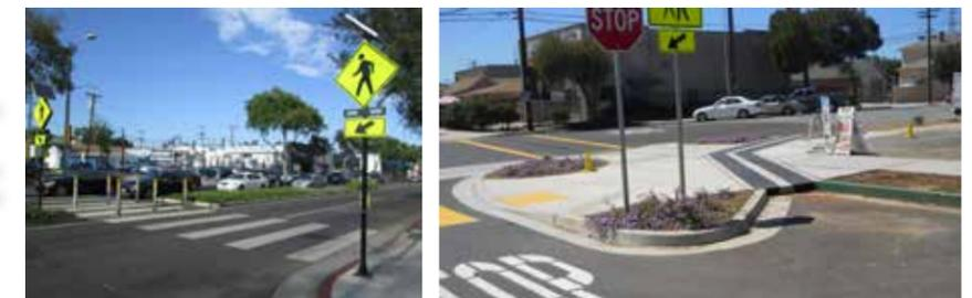
Diseños, tales como cruces peatonales de alta visibilidad, extensión de las aceras, rampas en las aceras y Luces Rectangulares de Centelleo Rápido (RRFBs, por sus siglas en inglés), aumentarían la seguridad de los peatones. Los diseños se instalarían en algunas de las intersecciones "Walk the Walk" y en las intersecciones de Sixth Avenue con las calles Grape, Juniper y Nutmeg.
